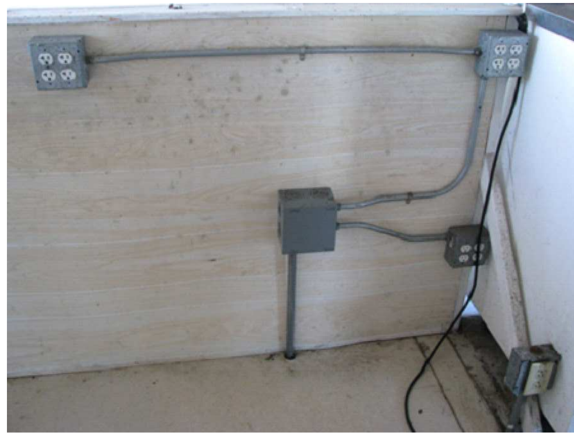
4 ELECTRIC CONDUITS D-002 - NTS
